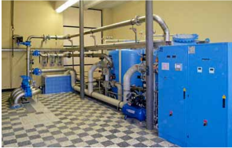
Neue Rohrleitungsführungen und Filtersandkessel in der Pumpstation des Wasserwerkes.
